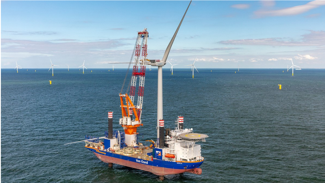
Εικόνα 6-1: Εργασίες εγκατάστασης πλωτών Α/Γ (Van Oord, 2023)
